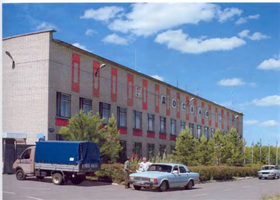
Здание горкома ДОСААФ.
