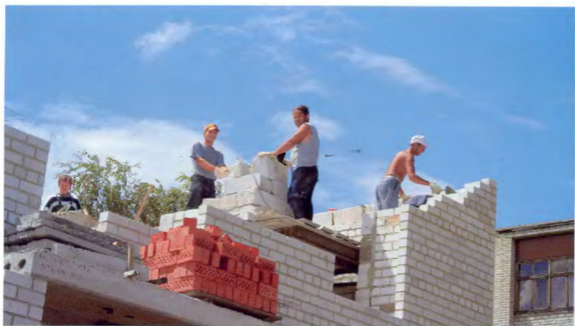
Строится новый дом.
