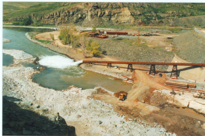
«Плененный» Урал – уникальная система пропуска воды из Ириклинского водохранилища во время ремонта на ГЭС в 2003 году
