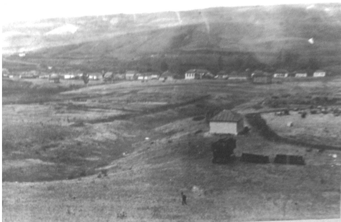
Село Блява. Первоначальная база строительства в 1933 г. Отсюда началось наступление строительства на площадку
