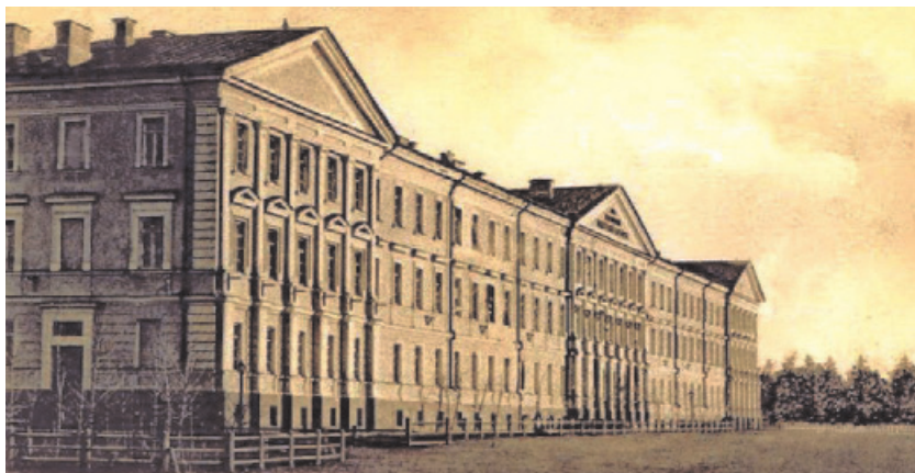
Рис. 13. Здание Оренбургской Неплюевской военной гимназии (с 1882 г. Оренбургского Неплюевского кадетского корпуса)
