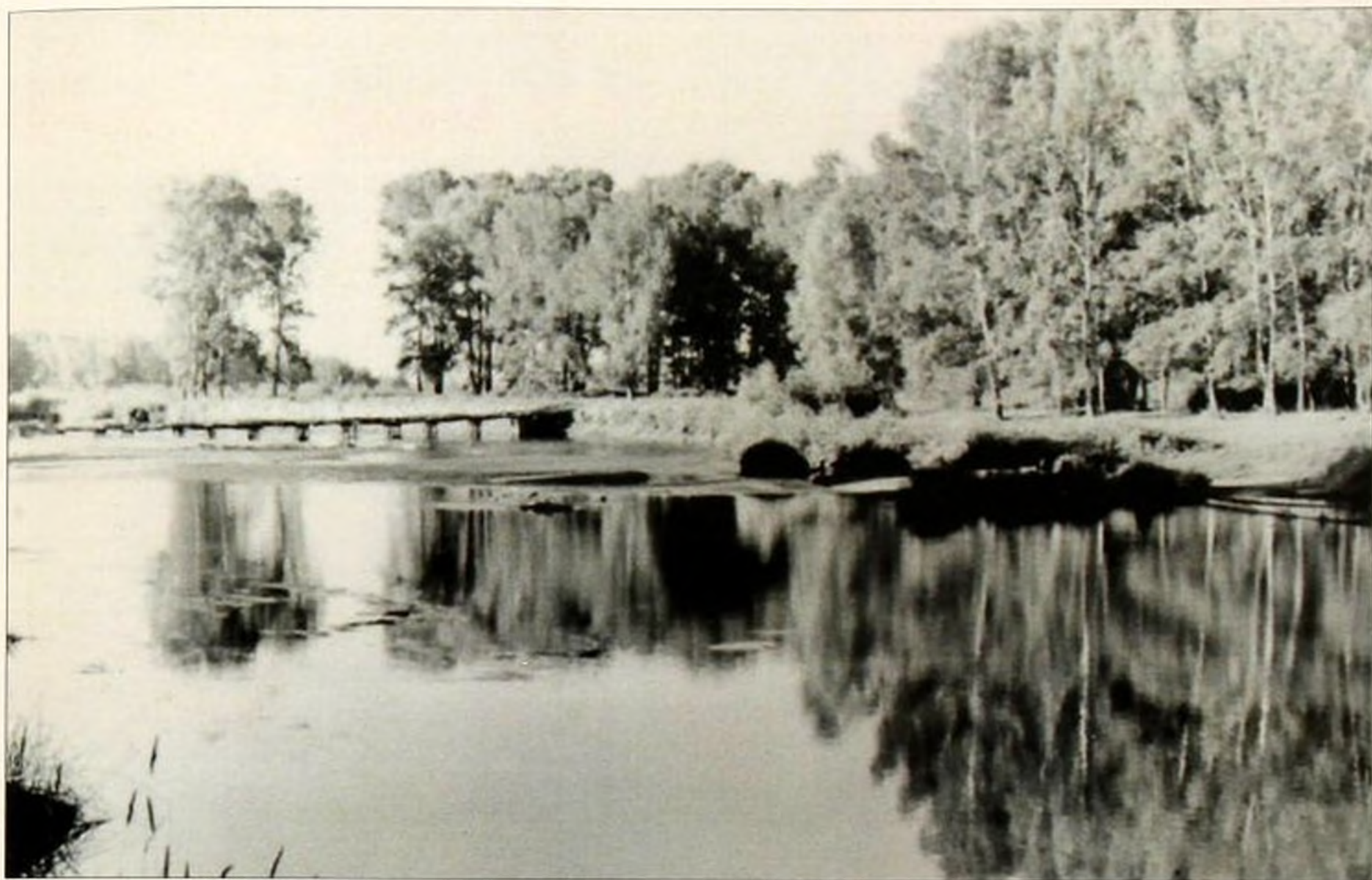
Мост через реку Большой Ик
