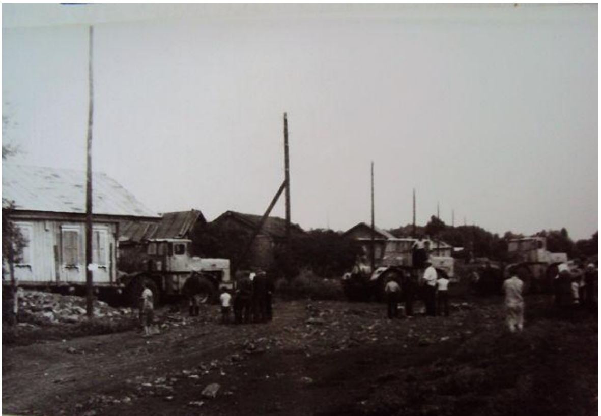
Установка дома пи помощи мощных тракторов «Кировец», 70 годы
