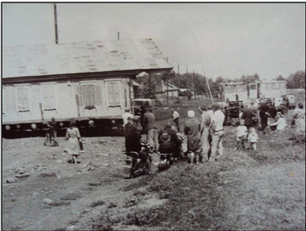
Улица Илечина, установка перемещенного дома, 60 годы
