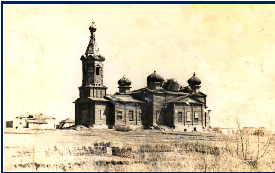
Церковь села перед разрушением (апрель 1962 г.)
