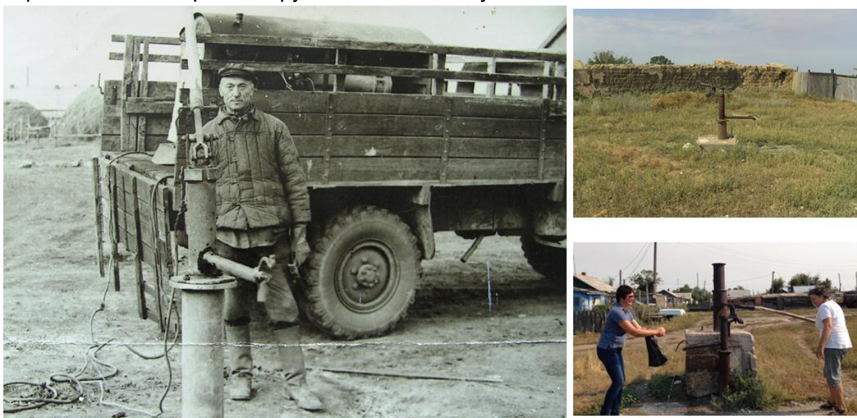
Рис. Пет-03. Слева: Яков Абрамович на монтаже колонки, на фоне грузового автомобиля со сварочной установкой в кузове. Обращает внимание на себя длинная деревянная рукоятка колонки! Справа: колонки конструкции Петкау все еще дают людям воду
