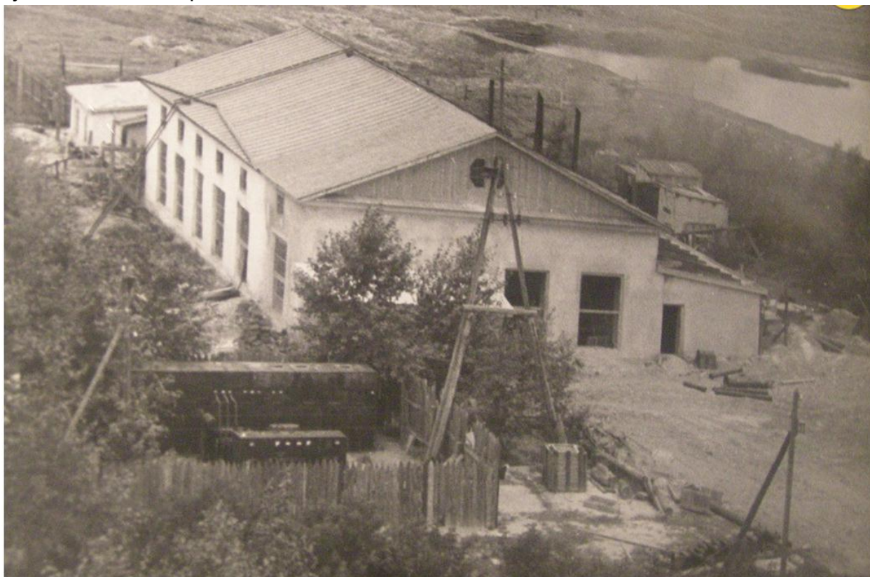
Рис. ГДХ-02. Дизельная электростанция, за ней расположен ремонтный цех двигателей, а справа виден пруд, в который сливалась вода после охлаждения моторов.
