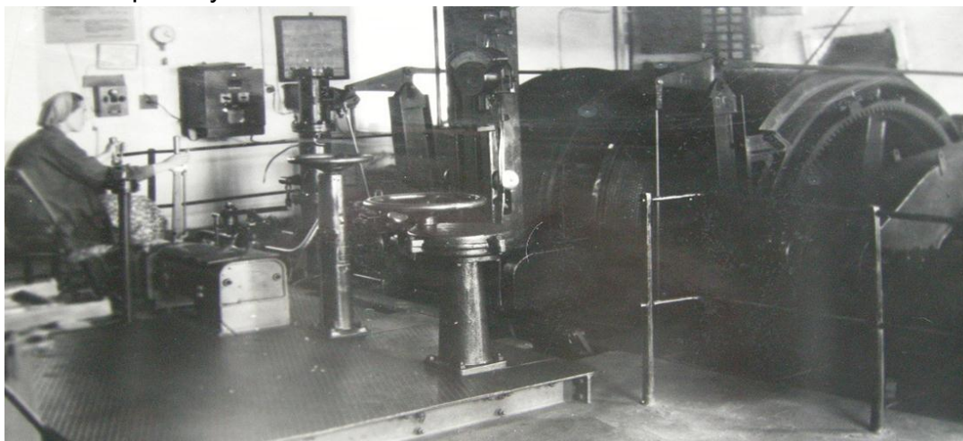
Рис. ТД3-12. Подъемная машина шахты «Новокапитальная». В качестве оператора машины работает женщина. Мне приходилось бывать в этом производственном помещении с моей тетей, Гергенредер Марией Филипповной – ее фото в правом нижнем углу. А сама фотография подъемной машины – из архива В. Кривенко
