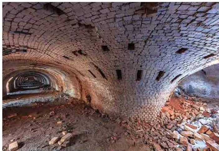
Кольцеобразная печь системы Фридриха Гофмана
