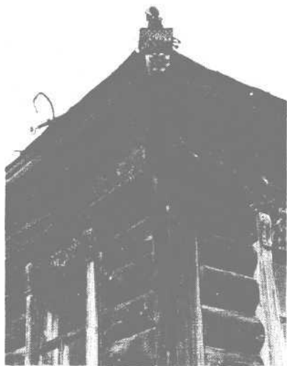
Рис.11. Челябинская область. Брединский район. Поселок Амурский. Дом Савельева. Водосток
