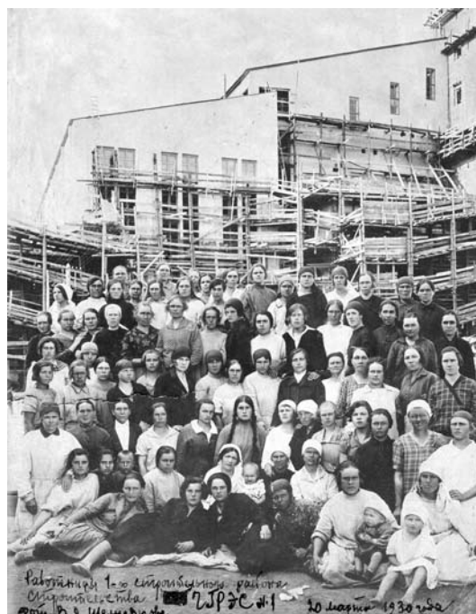
Работницы 1-го строительного района строительства ЧГРЭС № 1. 20 марта 1930 г. (ЧОКМ ОФ-2745/14, Ф-10708)
