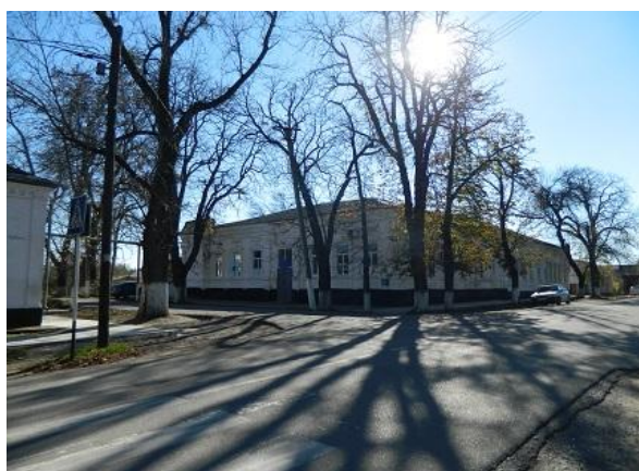
Рисунок 2. Здания первой больницы
