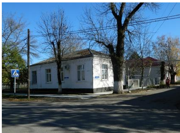
Рисунок 1. Здания первой больницы
