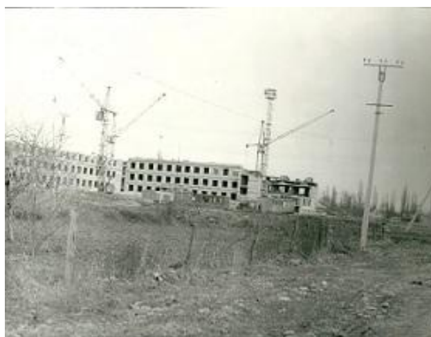
Рисунок 6 Строящееся здание центральной районной больницы
