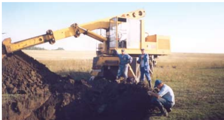
В. В. Гончаров на месте ремонта продуктопровода
