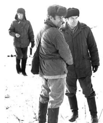
Участие М. С. Жучкова (справа) в учебных занятиях по порошковому тушению открытого газового фонтана на учебном полигоне. 1982 год
