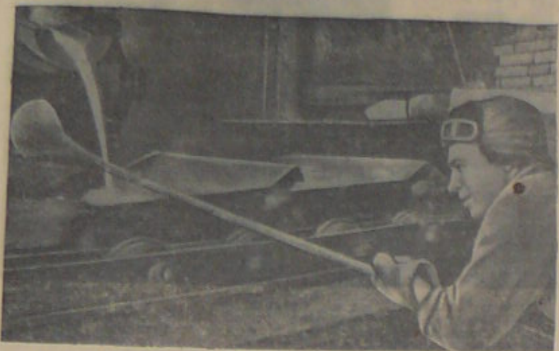
Старший горновой ватерважнетной печи № 2 медно-серного завода имени Чапаева тов. П. А. Шельневский наблюдает за выходом расплавленного шлака из ватерважнетной печи. Шлак стекает в шлакоразливочную машину. Фото В. Елагина.
