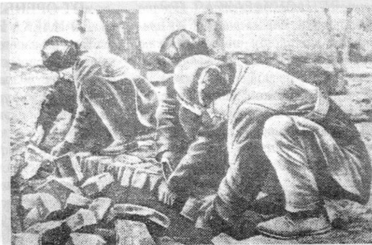
Начались работы по переоборудованию Советской улицы. На снимке: рабочие дормостоотдела (справа налево) Зидов, Зубков и Кузьмин перемещают середину улицы
