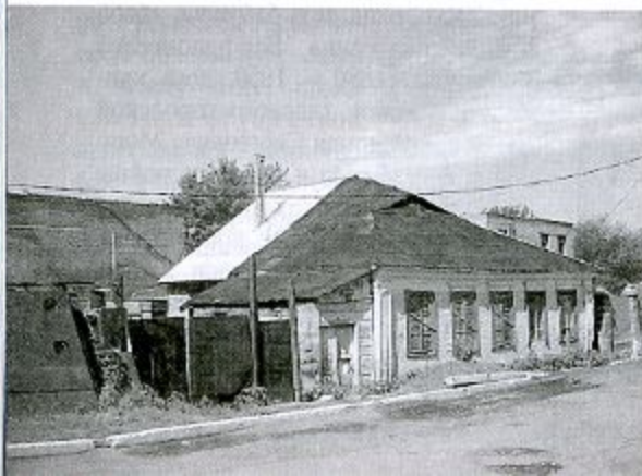
Остатки фасада дома по ул. Набережной, 1 (без старинных ворот). 2010 г.
